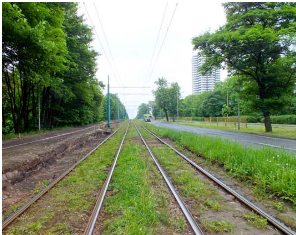
Torowisko na ulicy Chorzowskiej w Katowicach przed modernizacją
