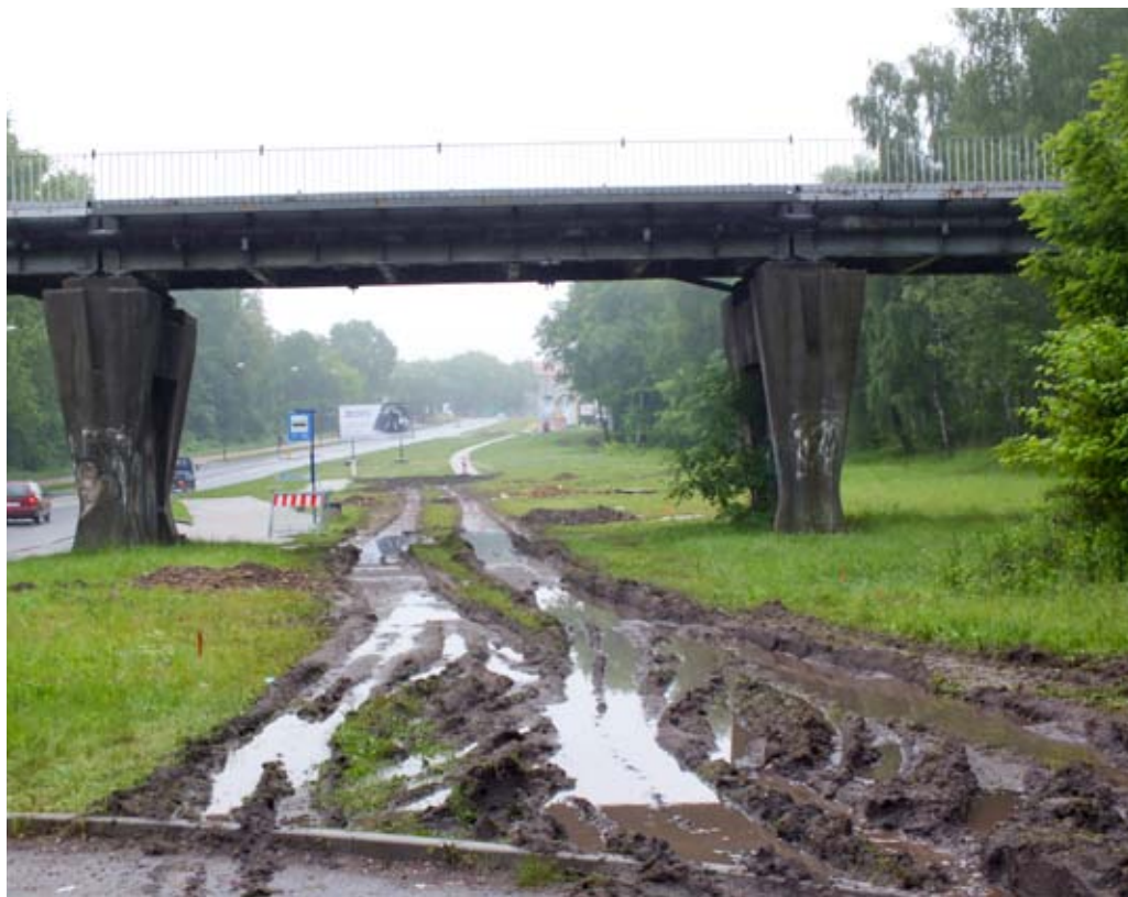
Teren przed odbudową torowiska na ulicy Łągiewniczej w Bytomiu
